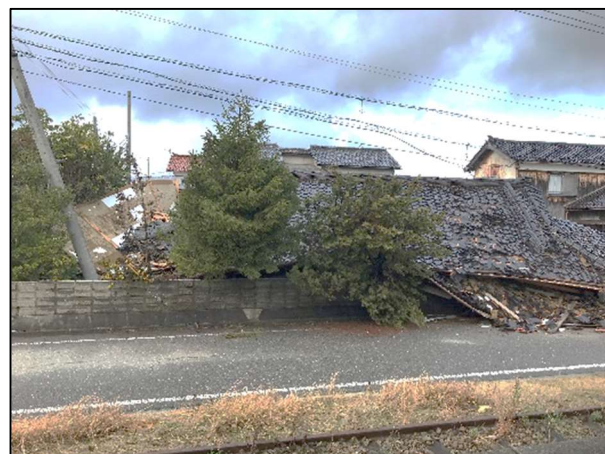
倒壊した家屋
